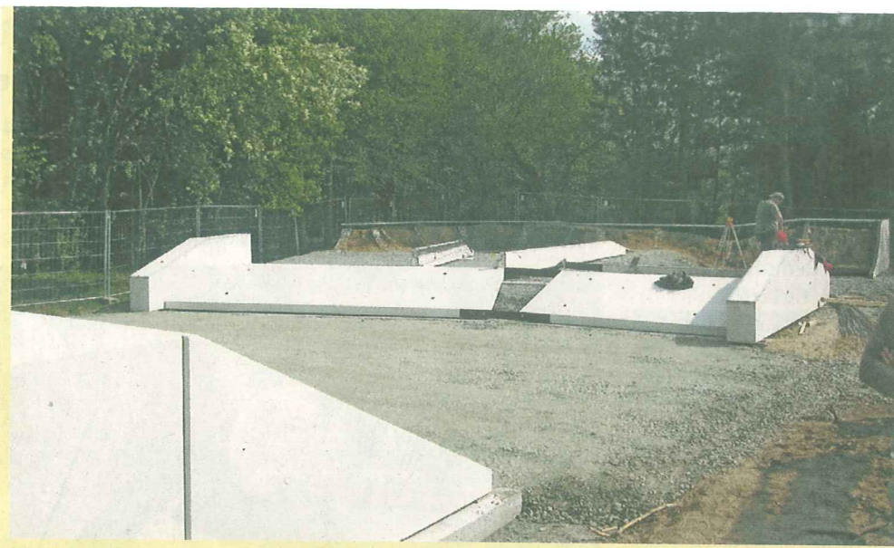
Das Foto zeigt den Baustand Mitte April. Mittlerweile ist der Bau schon weiter vorangeschritten.
